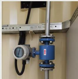
法拉第电磁感应测量
